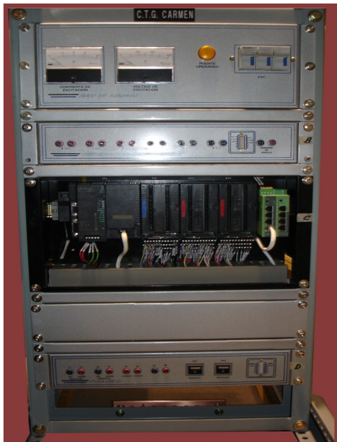
CABEZAL ELECTRÓNICO Y PUENTE RECTIFICADOR . TIPO BRUSHLESS
